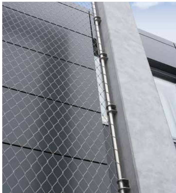
Stehende Masche_Vertical mesh diamond direction
