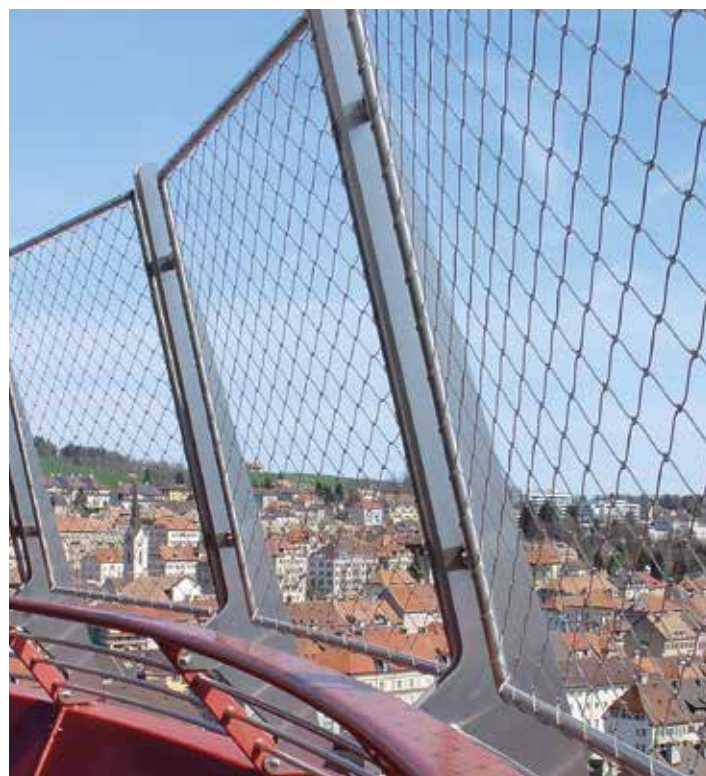
Liegende Masche_Horizontal mesh diamond direction
